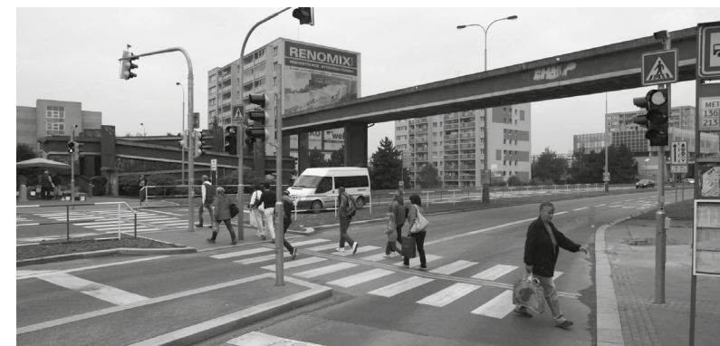
[ OBR. 19 ] Nevhodně řešené mimoúrovňové křížení pěšího pohybu s komunikací. Pro nefunkčnost byl nakonec paralelně zřízen úrovním přechod. Jižní Město, Praha
