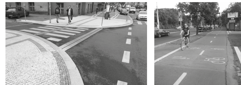
[ OBR. 20 ] Příklad chodníkového přejezdu (vlevo) a stezkového přejezdu (vpravo)
