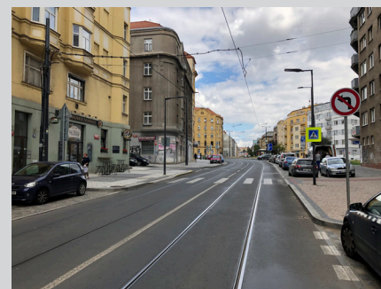
Příklad přechodu pro chodce s vysazenými chodníkovými plochami, stavebním zajištěním volnosti příslušných rozhledových trojúhelníků a přisvětlením přechodu.
