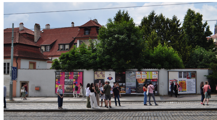
Klárov, Praha, 2023 V historické, středověké zástavbě můžeme nalézt rozhraní mezi veřejným a soukromým prostorem (často zahradami) formou zdí.
