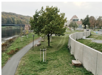
nová protipovodňová stěna
