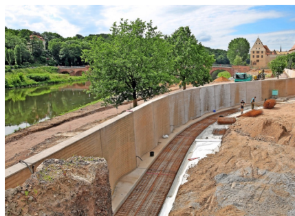
nová protipovodňová stěna
