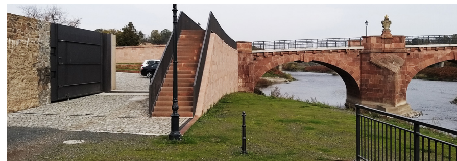
integrace městské hradby a nová protipovodňová stěna
