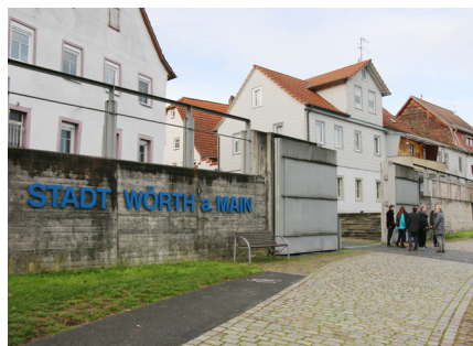
nová protipovodňová stěna s mobilními prvky
