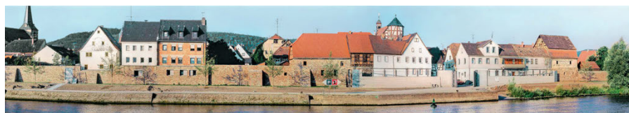
13 panorama nábřeží s protipovodňovou ochranou
