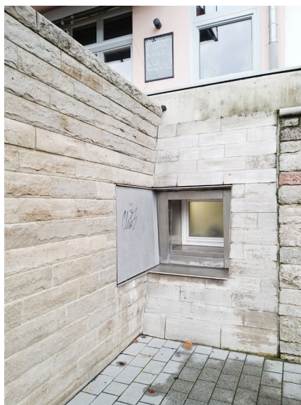
detail integrovaného okenného otvoru
