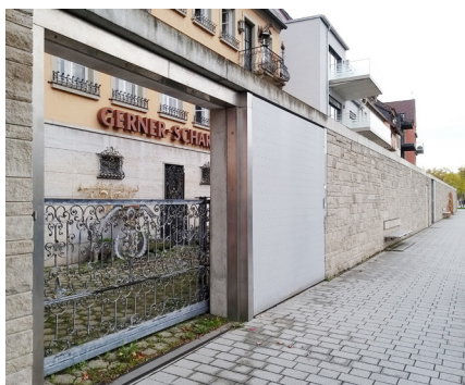
nábřeží - protipovodňová vrata
