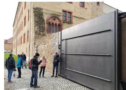
protipovodňová vrata v hradební zdi
