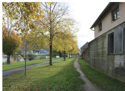
předsazená protipovodňová stěna
