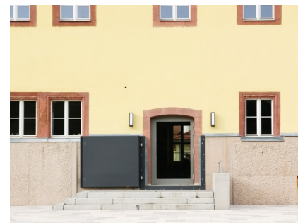
protipovodňová vrata v předsažené protipovodňové stěně
