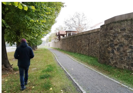
19 městská hradba jako součást protipovodňového systému
