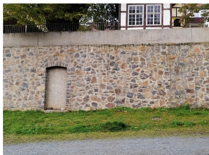
městská hradba jako součást protipovodňového systému
