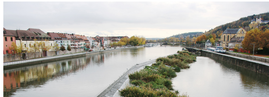
panorama města s protipovodňovou ochranou
