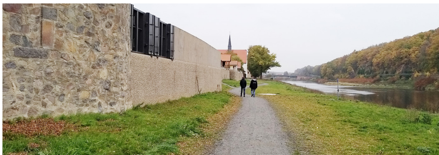
integrace městské hradby a nová protipovodňová stěna
