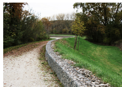
navýšení hráze pomocí gabionů
