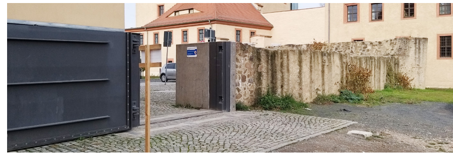
městská hradba jako součást protipovodňového systému
