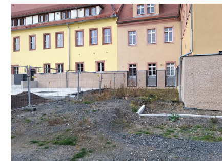
předsažené protipovodňové stěny
