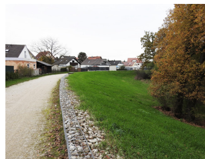
navýšení hráze pomocí gabionů
