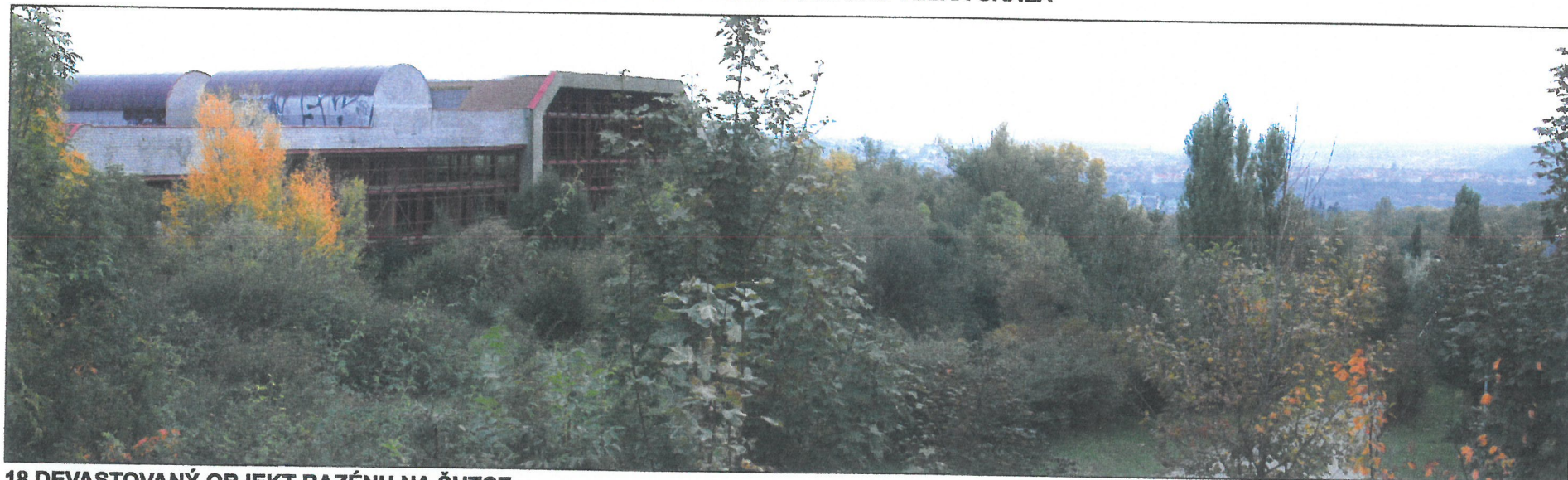
18 DEVASTOVANÝ OBJEKT BAZÉNU NA ŠUTCE
