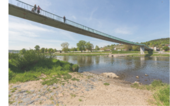
Pod lávkou je vidět zádlážba břehu. Odkrýváme a zpřístupňujeme břežní koryto ve větším rozsahu.
