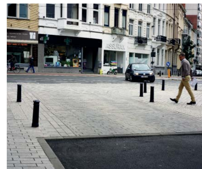
OBR 240.11 Napojení vedlejší ulice na hlavní městskou třídu Vozovka je v úrovni chodníku a ve stejném materiálu (Belgie, Gent)
