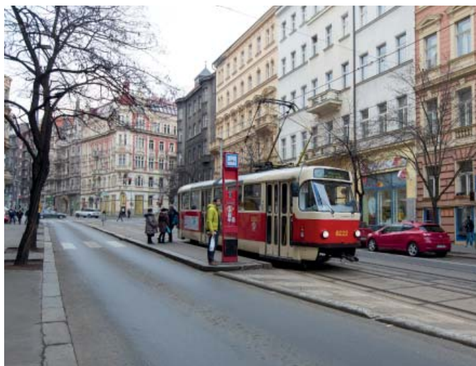
OBR 220.1 Tramvajová zastávka Italská Nástupní ostrůvek je příliš úzký a přístup na něj není bezbariérový.
