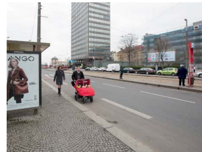
OBR 220.4 Tramvajová zastávka Želivského Malá šířka chodníku je ještě omezena přístřeškem tramvajové zastávky a sloupy trakčního vedení. Chybí bezbariérový a bezpečný přístup na nástupní tramvajový ostrůvek.
