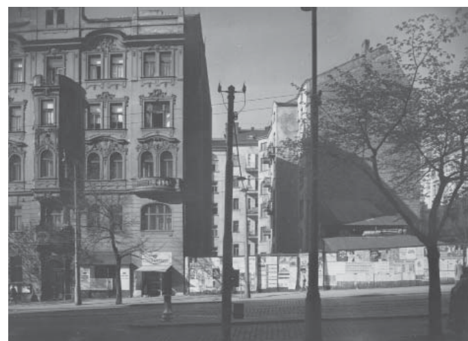
OBR 260.2 Proluka po domech vybombardovaných během konce 2. sv. války, dnes zde stojí budova Finančního úřadu Prahy 2
