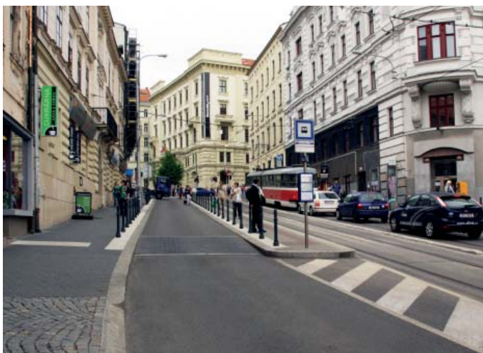
OBR 210.9 Tramvajová zastávka Šilingrovo náměstí, Brno Ostrůvek se zvýšenou plochou vozovky včetně bezbariérových úprav pro nevidomé.
