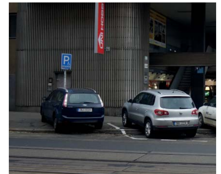
OBR 240.14 Současná vyhrazená stání pro ZTP Příklad stávajícího vyhrazeného stání pro vozíčkáře před budovou VZP, stání je zpoloviny na chodníku a zpoloviny ve vozovce, stání je bariérové a neumožňuje manipulaci s invalidním vozíkem kolem auta
