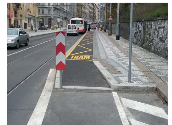
OBR 230.6 Cyklovídeňská zastávka Krymská ve Francouzské ulici Realizovaná cyklovídeňská zastávka ve stoupání ve Francouzské ulici v Praze.
