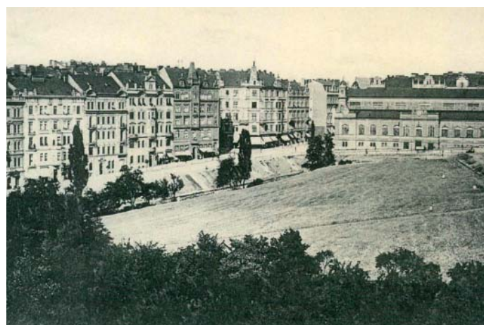
OBR 1.2 1903 - stále ještě nezastavěné pozemky Seidlova pole - dnes zde stojí městské paláce (Radiopalác, palác Orbis, Maceškův palác) a obchodní akademie), v pozadí budova Vinohradské tržnice. Patrný je také rozdíl navážky Vinohradské ulice a původního terénu.
