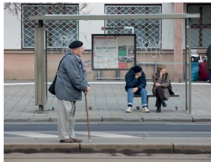
OBR 220.3 Tramvajová zastávka Olšanské hřbitovy Přístřešek není umístěn na nástupním ostrůvku, zejména starší lidé ho nedokážou využít.
