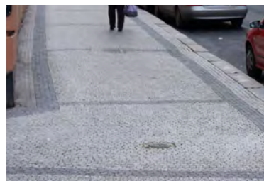
2b| Balbínova kobercová dlažba, předělné pásy
