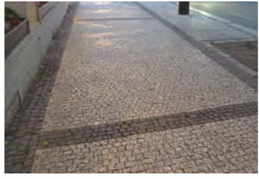
35| Vinohradská kobercová dlažba, předělné pásy
