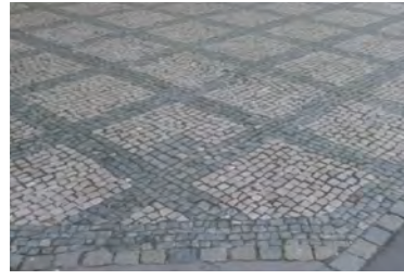
21| Vinohradská 109 rám, kladený na kolmo, orientace k obrubě
