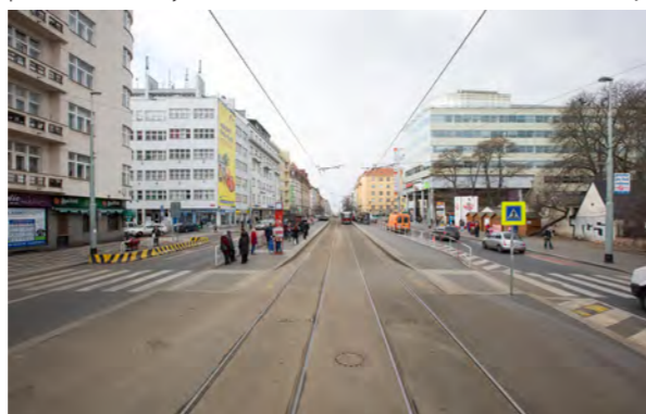
Tramvajová zastávka Flora
