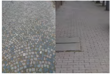
28a/b| Boleslavská a-kobercová dlažba, kroužková b-betonové dlaždice
