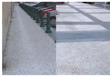
27a/b| Orlická a-kobercová dlažba, b-kobercová s příčnými pásy
