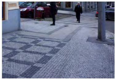
8| Vinohradská sedmdesátka, kladená na kolmo, orientace k obrubě
