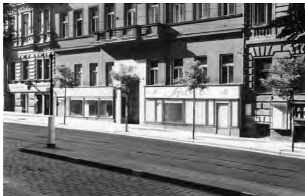
1939| ostrůvek tramvajové zastávky Italská
