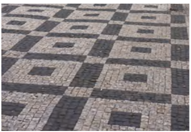
48, 54| Vinohradská sedmdesátka s dámou, kladená na kolmo, orientace k obrubě
