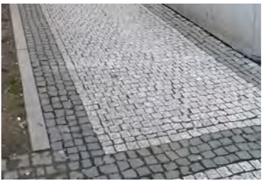
16a| Nitranská kobercová dlažba s předělnými pásy
