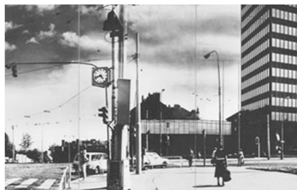
1982| křižovatka Želivského - pohled na budovu Strojimportu
