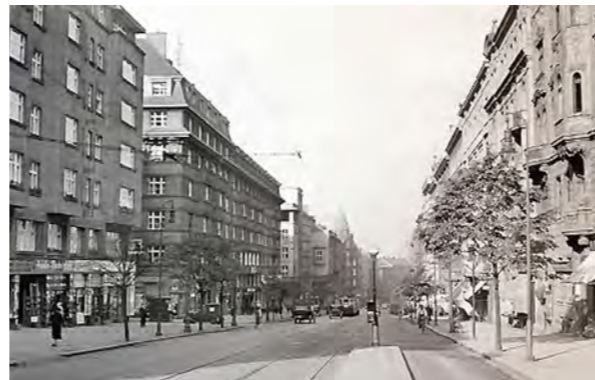
1935| nároží Vinohradská-Sázavská - po levé straně městské paláce na bývalém Seidlově poli
