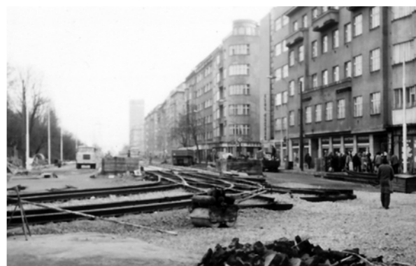
1979| Flora - pokládka kolejí v úseku Flora - Želivského [zdroj: archiv DP Praha]
