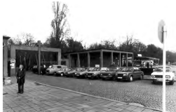
1988| hlavní vstup do areálu Olšanských hřbitovů [foto: J. Straka]
