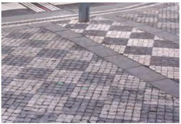
12| Vinohradská tržnice dáma, kladená na koso, orientace k obrubě
