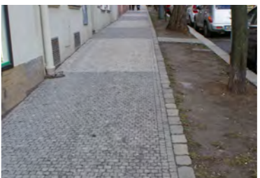
16b| Nitranská kobercová dlažba, střídavě světlá/tmavá
