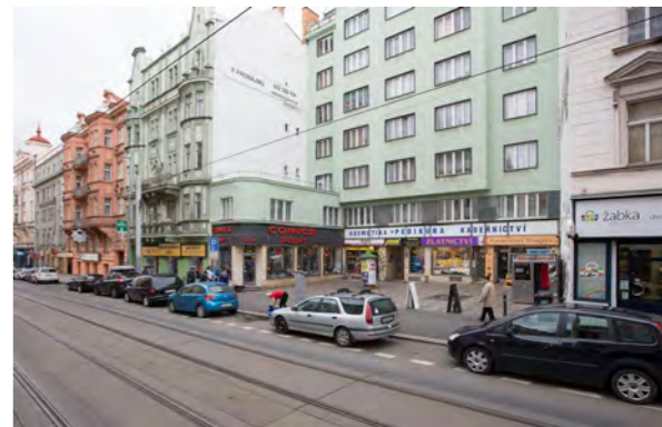
Rozšíření pěšího prostoru při ústí ulice Perunovy před funkcionalistickým obytným domem č.p. 111 [foto: J. Malý]
