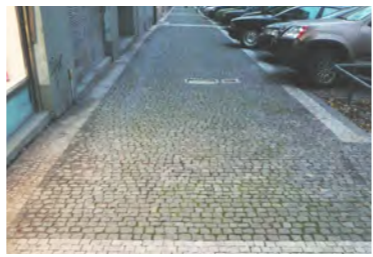
31, 33| Baranova, Sudoměřská kobercová dlažba, předělné pásy
