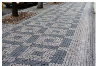
9| Vinohradská 938 sedmdesátka s dámou, kladená na kolmo, orientace k obrubě
