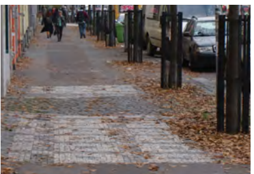
16c| Vinohradská 1678 sedmdesátka s dámou, kladená na kolmo, orientace k obrubě
