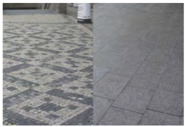
37a/b| OC Flora a-drak v rámu, kladený na koso, b-velkoformátová dlažba
