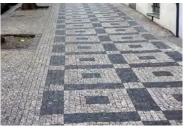
13a+b| Třebízského sedmdesátka s dámou, kladená na kolmo, orientace k obrubě
