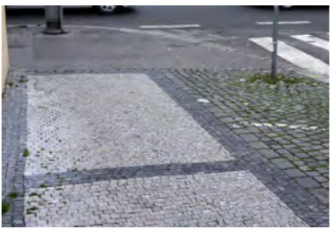
11a+b| Blanická kobercová dlažba, předělné pásy, parkování - kroužková dl.
