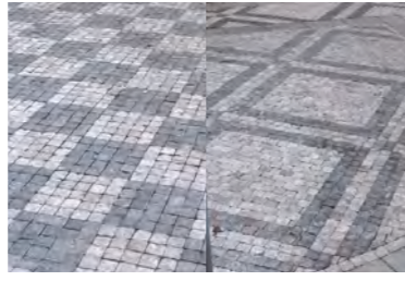
29a/b| Radhošťská a-dáma, kladená na koso, b-rám (atypický), kladený na koso
