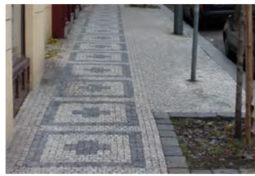
3a| Balbínova kříž v rámu, kladen na kolmo
