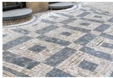
23a| Vinohradská 113/87 sedmdesátka s dámou, kladená na kolmo, orientace k obrubě
