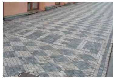
19| Vinohradská 105 dáma, kladená na koso, orientace k obrubě
