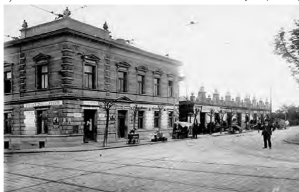
po r. 1900| nároží Vinohradská-Jičínská - restaurace Na křižovatce
