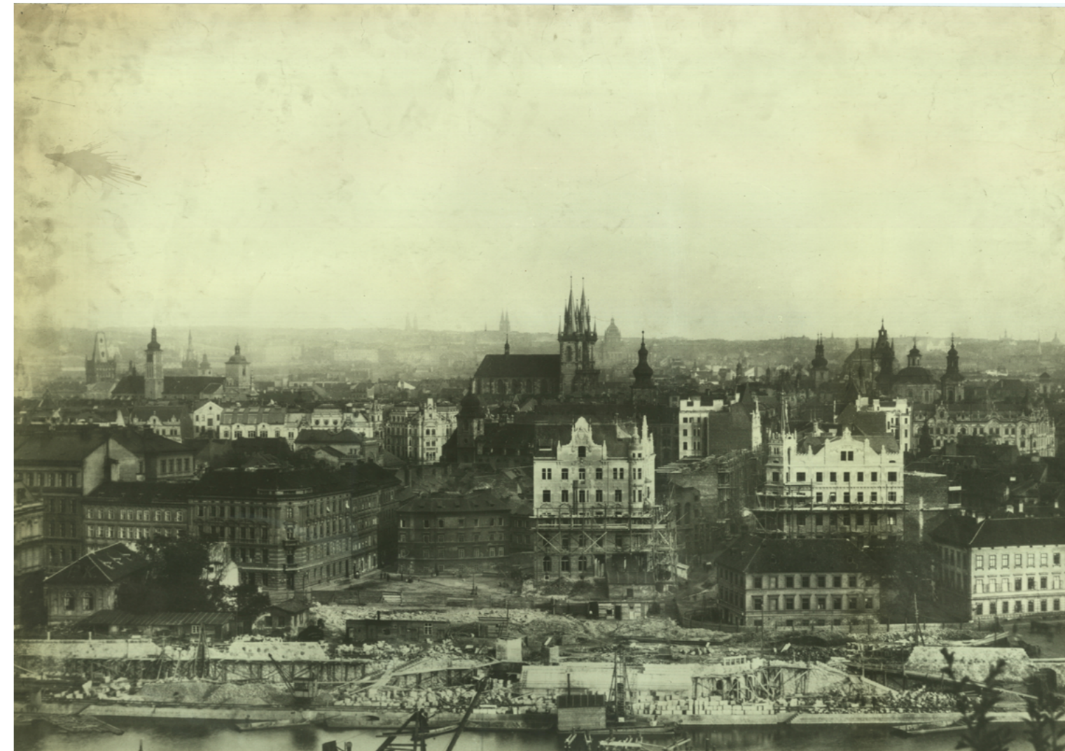
1906 stavba Čechova mostu; Foto: Archiv IPR Praha
