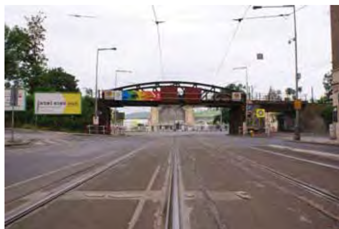
OBR 110.1 ul. Dukelských hrdinů - komponovaná osa Ulice Dukelských hrdinů je zakončena nástupním prostorem výstaviště a středním traktem Průmyslového paláce jako hmotovým vyvrcholením
