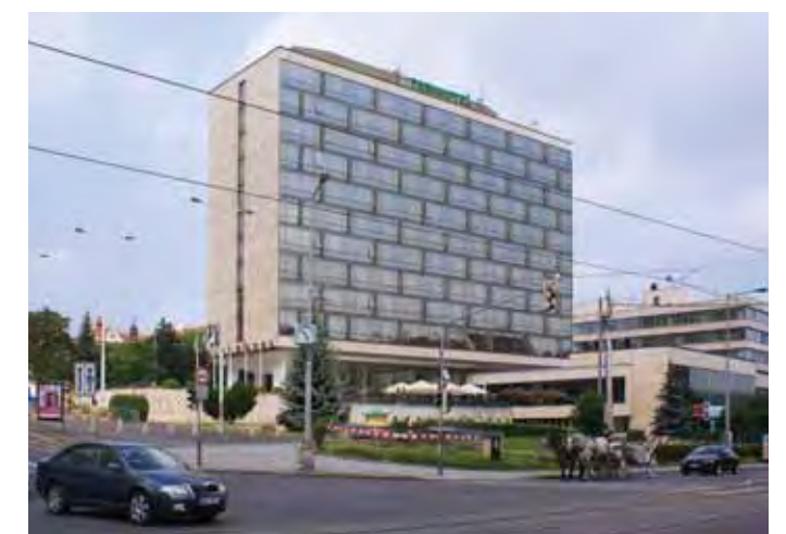
OBR 110.15 budova Parkhotelu Dílo architektů Zdeňka Edela a Jiřího Lavičky bylo vyprojektováno roku 1959. Hotel byl roku 1967 otevřen především jako nabídka ubyt. kapacit pro sousední Veletřní palác. V současnosti (2018) probíhá rekonstrukce (Mama Shelter)
