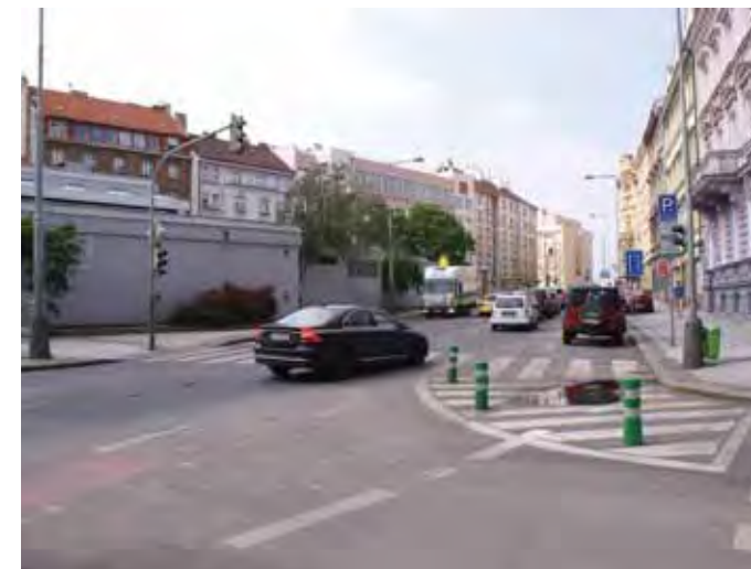
OBR 110.11 Letenské náměstí - Veletřní Provizorní úprava balisety a dopravními stíny při ústí ul. Veletřní na Letenském náměstí
