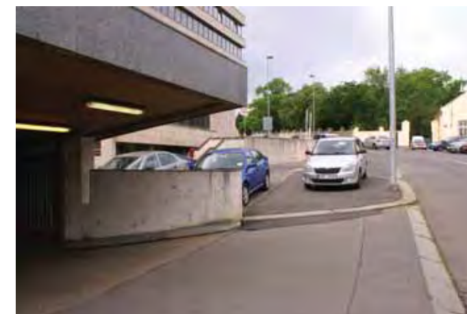
OBR 110.8 Pěší prostor před budovou policejního prezidia západní část ulice Strojnická je z pohledu chodce neatraktivní až nepřátelská. Před budovou policejního prezidia dochází pravidelně k nedovolenému parkování automobilů na chodníku
