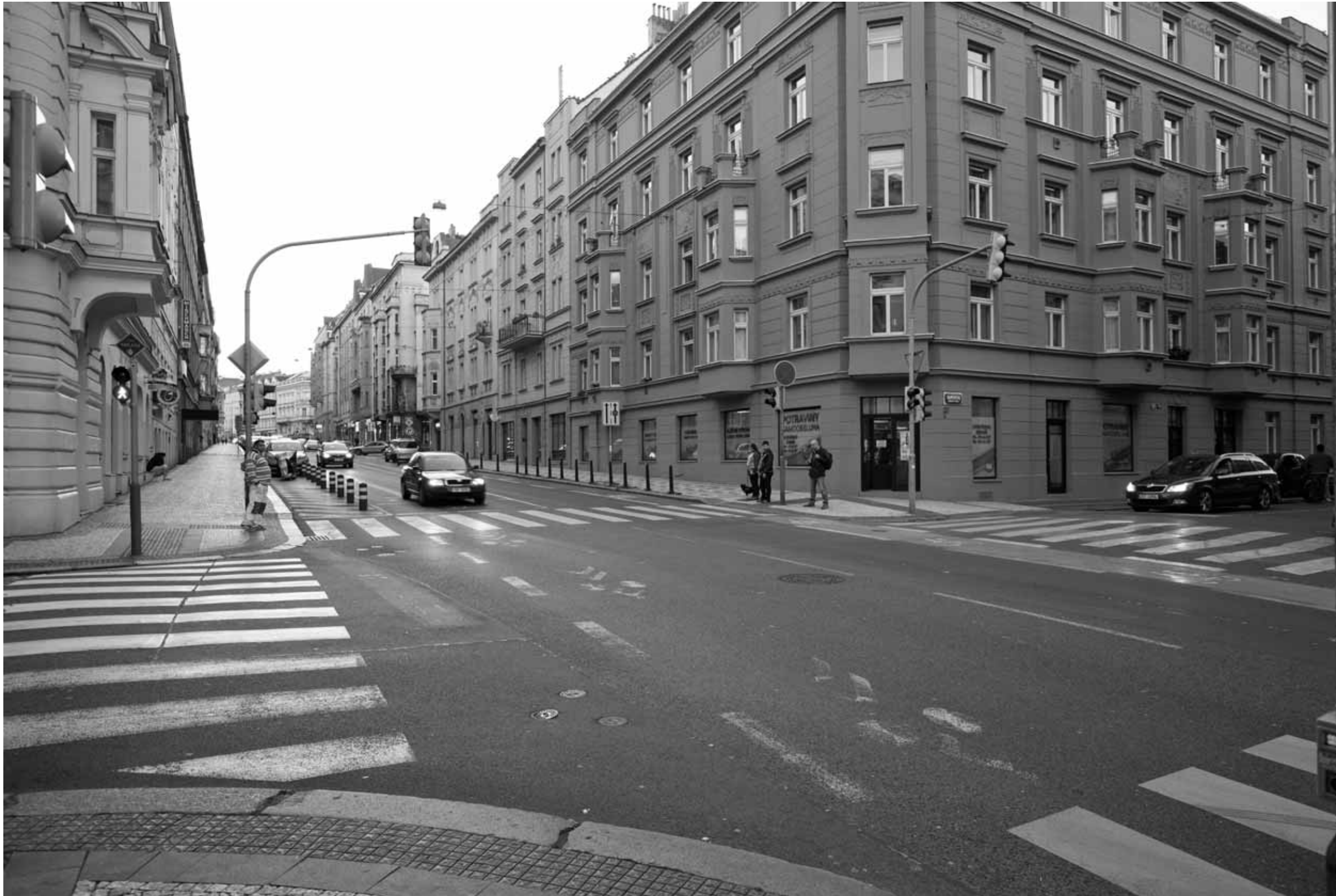
OBR 1.9 Současný stav - ulice Veletržní pohled z nároží křižovatky Veletržní / Kamenická
