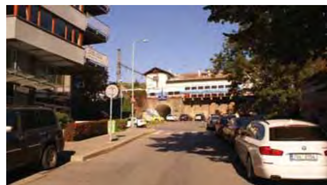
Ulice Paříkova - podchod k nádraží Praha - Vysočany
