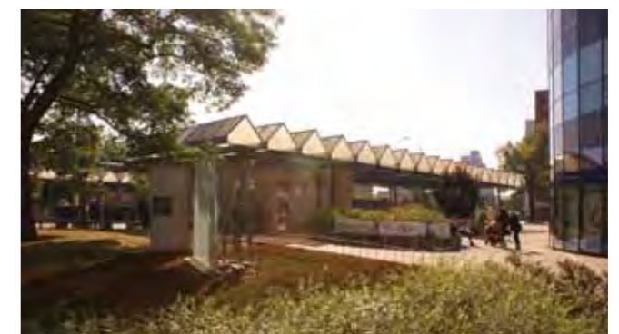
vstup do metra - přístřešky vstupů do metra na křižovatce Freyovy a Sokolovské
