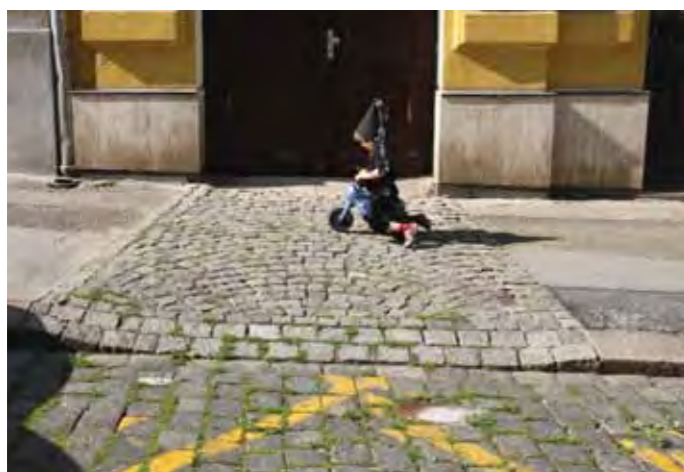
Princip odlišení vjezdů do objektů štípaná žulová dlažba 10x10cm - 12x12cm
