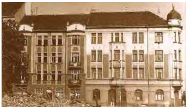
Krátkého ulice po demolici restaurace U Lípy
