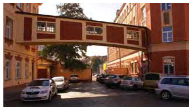
Pod Pekárkami - krček mezi budovami v rohu ulice Pod Pekárkami
