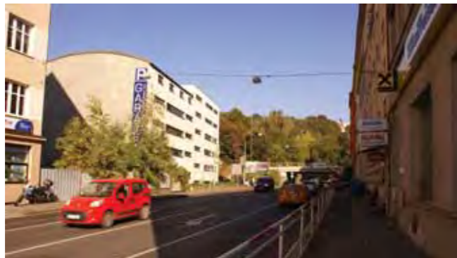
Jandova - podjezd pod železniční tratí v ulici Jandova
