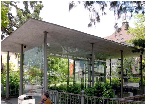
567 Kultivované řešení vstupu do podzemí. Odlehčení objemu napomáhá subtilní konstrukce kvalitní materiály a detaily [ Švýcarsko, Chur ]
