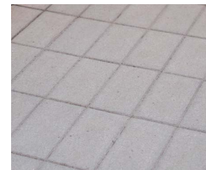
285 Velkoformátová betonová dlažba
