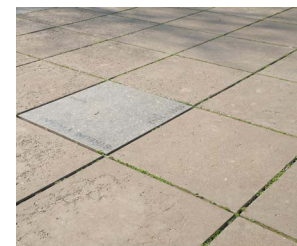
286 Velkoformátová betonová dlažba
