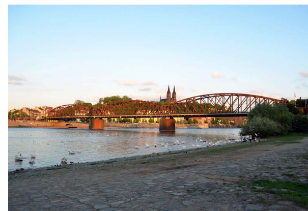
022 Kontrast kamenného města s krajinným elementem řeky tvoří obraz Prahy, který je třeba podporovat. Vizuální kontakt s pražskými dominantami dotváří charakter a význam jednotlivých nábřeží [ Praha 5, Smíchov ]
