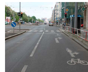
103 Přímý průjezd jízdních kol pravým odbočovacím pruhem minimalizuje vzájemné omezování vozidel a jízdních kol v levém pruhu [ Praha 4, Na Pankráci ]
