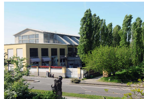
054 Průmyslový areál je vhodně integrován do prostředí parku. Topoly přirozeně rostoucí vně areálu se objevují i uvnitř, čímž se pohledově stírá rozdíl mezi prostředím areálu a okolím [ Itálie, Milano, Parco Nord ]
