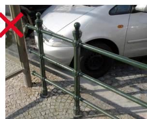
496 Nově vybudované historizující zábradlí mimo historické město není z hlediska tvarosloví vhodné [ Praha 6, Svatovítská ]
