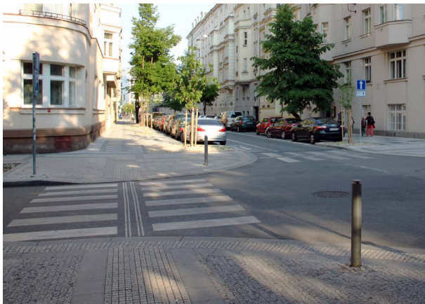
105 Křižovatka zklidněných ulic s vysazenými chodníky sníženými do úrovně vozovky a přechody na všech ramenech křižovatky [ Praha 6, Eliášova ]
