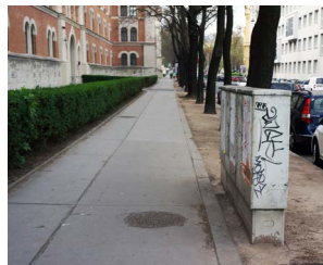
364 Skříně technické infrastruktury může být vhodné umístit do prostoru výsadbového pásu stromořadí [ Rakousko, Vídeň ]
