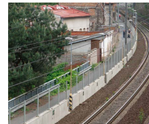
530 Příklad nízké protihlukové stěny podél železničního koridoru [ Kolín, Rybářská ]
