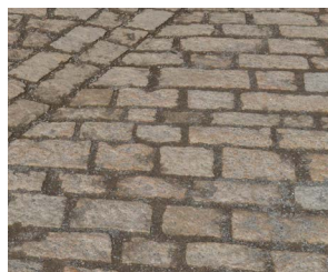
270 Žulová žíhaná dlažba velkého formátu Použití: sdílené komunikace, zvýšené křižovatky, parkovací zálivy, parkoviště historického a kompaktního města
