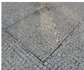
353 Vhodný „neviditelný“ povrch poklopu, který materiálově a výškově navazuje na okolní povrch [ Praha 6, Bubeneč ]
