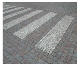
223 Vhodné materiálové řešení přechodu pro chodce, nahrazující vodorovné značení nátěrem [ Vysoké Mýto, náměstí Přemysla Otakara II. ]
