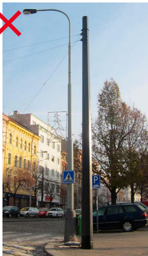
373 Dublování sloupů trakčního tramvajového vedení a veřejného osvětlení je třeba předcházet sdružováním jejich funkcí. Není vhodné zachovávat současný stav, kdy jsou často i při rozsáhlých rekonstrukcích vedle sebe umístovány a ponechávány sloupy trakčního vedení tramvaje a veřejného osvětlení [ Praha 10, Moskevská ]
