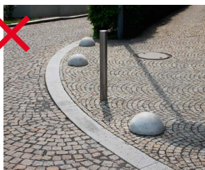
506 Používání nízkých patníků je, zejména s ohledem na nebezpečnost a zakopávání, většinou nevhodné [ Praha 8, Sokolovská ]
