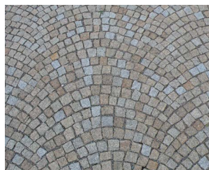
266 Kroužková žíhaná žulová dlažba malého formátu 6 x 6 cm Použití: sdílené komunikace, zvýšené křižovatky, parkovací zálivy, parkoviště historického a kompaktního města
