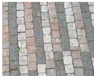
264 Řezaná pražská mozaika Použití: chodníky podél budov kompaktního a historického města Poznámka: Pro správné vyniknutí vzorů je třeba užívat materiál výrazně odlišné barevnosti.
