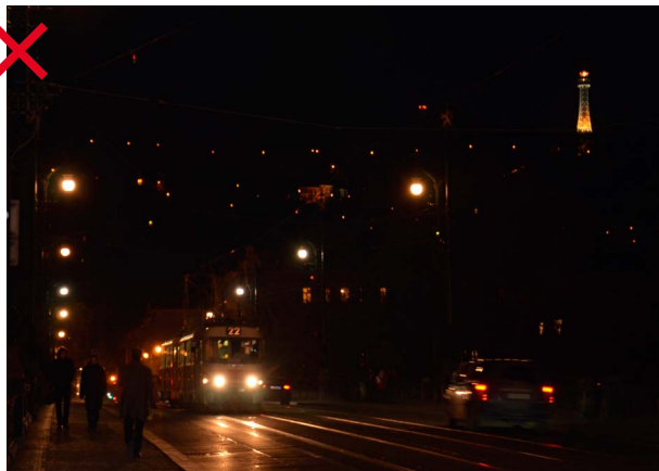
403 Nevhodný charakter vyzařování svítidel vytvářející nedostatečné osvětlení pozemní komunikace a způsobující oslnění a nedostatečný vjem chodců [ Praha 1, most Legií ]
