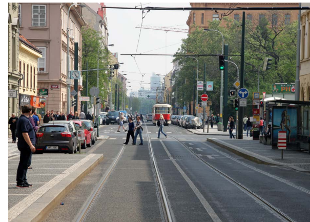
079 Významná zklidněná ulice s bezbariérovými zastávkovými mysy [ Praha 8, Sokolovská ]
