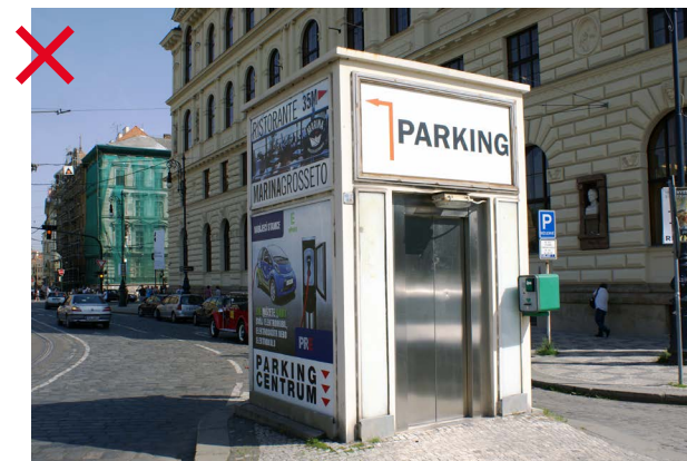
566 Příklad vyústění výtahu, které mimo jiné díky celoplošnému polepu reklamou dominuje svému okolí a omezuje významné pohledové osy [ Praha 1, náměstí Jana Palacha ]
