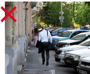
179 Nevhodná úprava šikmého stání stavebním provedením na chodníku, kde parkující vozidla zužují průchozí profil [ Praha 6, Bubeneč ]
