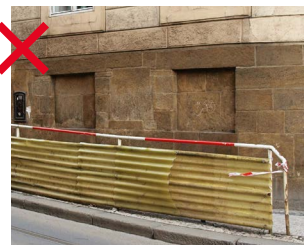
494 Nevhodná výplň zábradlí neadekvátní městskému prostředí, která působí dočasným dojmem a morální dožilostí již v době instalace a zároveň neumožňuje průhled [ Praha 1, Smetanovo nábřeží ]
