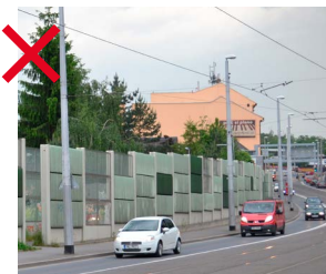
532 Protihlukové stěny užívané na městských komunikacích, které mají potenciál být městskou ulicí je zásadně nevhodné [ Praha 5, Radlická ]
