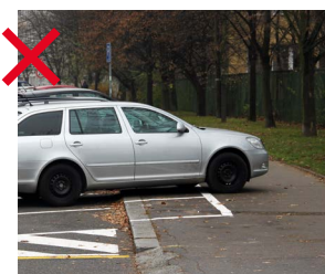
178 Nevhodná úprava šikmého stání formou dopravního značení na chodníku, kde parkující vozidla zužují průchozí profil [ Praha 9, Lovosická ]
