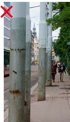
370 Nekoncepční umístění sloupů trakčního tramvajového vedení do prostoru chodníku pouze dle požadavků na statiku vytváří bariéry pro pohyb po chodníku a degraduje celkové vnímání prostoru náměstí [ Praha 2, Karlovo náměstí ]
