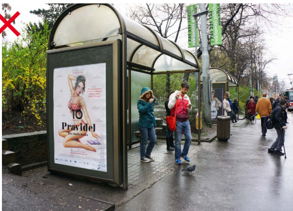
452 Špatně umístěný a obtížně udržovatelný přístřešek [ Praha 2, Karlovo náměstí ]
