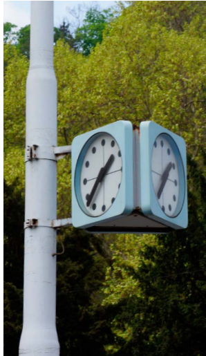
483 Typické pražské hodiny, které mají kvalitní design a jsou dobře čitelné. Lze je kotvit i na sloupy veřejného osvětlení [ Praha 5, náměstí Kinských ]
