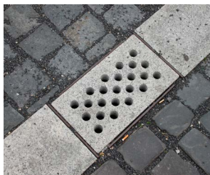
352 Možný příklad prvku odvodnění ulice z materiálu, shodného s navazujícím povrchem [ Frýdlant ]
