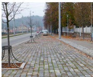
321 Integrace parkování a stromořadí, široká spára dlažby umístěná mimo chodník umožňuje zasakování vody [ Brno, Hlinky ]
