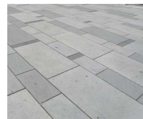
275 Velkoformátová kamenná žulová dlažba různé barevnosti a formátů Použití: pochozí plochy pěších zón, náměstí, nádvoří, piazzety historického a kompaktního města
