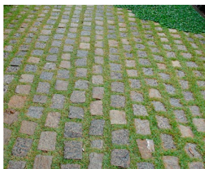
289 Kamenná dlažba se zatravněnou spárou Použití: zásadbový pás stromořadí, parkoviště, chodníky zahradního města
