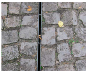
354 Liniové štěrbinové odvodnění je nenápadné a estetické, ale bývá problematické z hlediska údržby [ Německo, Berlín ]
