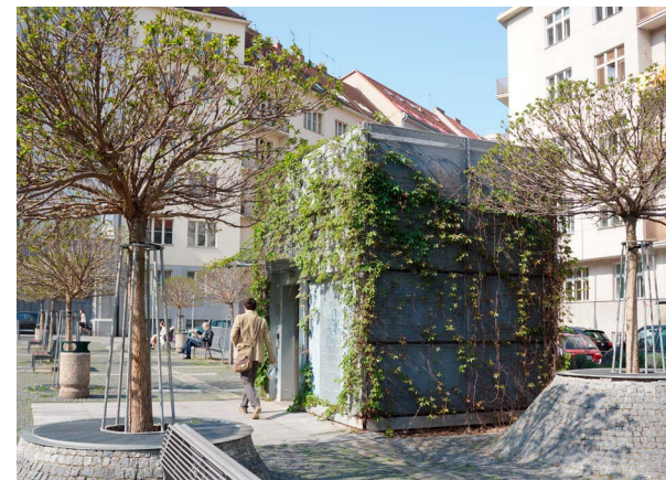
565 Příklad vyústění výtahu, které je začleněno do architektonické kompozice prostранství [ Praha 6, Kyjevská ]
