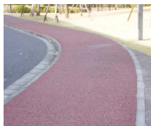
294 Probarvený asfalt Použití: vytížené chodníky uvnitř parků, cyklostezky apod.
