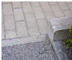
281 Maloformátová betonová dlažba
