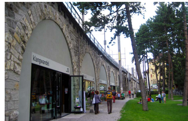
063 Viadukt v městském prostředí nevytváří takovou bariéru jako vedení železnice na valu. Je propustnější pro pohyb a oblouky viaduktu se dají využít i jako alternativní parter, čímž ožívají přilehlá prostranství [ Švýcarsko, Curych ]
