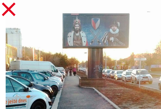
576 Samostatně stojící stavba pro reklamu, která vedle toho, že má příliš velké rozměry, omezuje pohyb ve veřejném prostoru [ Praha 4, Podolí ]
