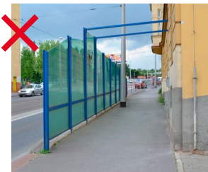
533 Protihlukové stěny užívané na městských komunikacích, které mají potenciál být městskou ulicí je zásadně nevhodné [ Praha 5, Radlická ]
