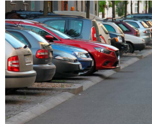
220 Vhodné vymezení parkovacího zálivu mírným zvýšením a použitím jiné dlažby, než je povrch vozovky [ Praha 7, Bubeneč ]
