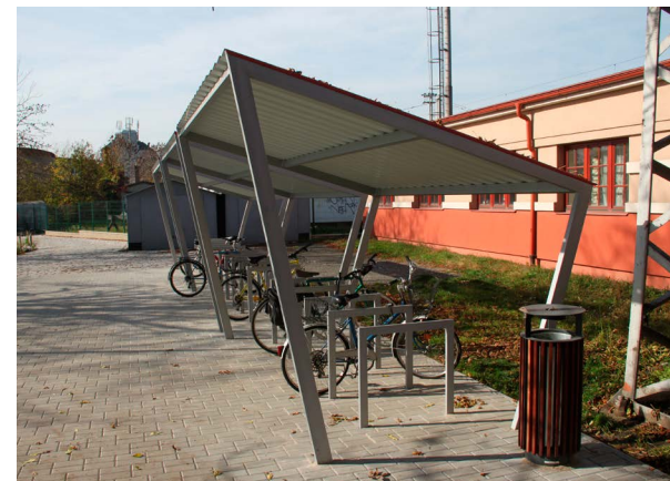
431 Zastřešené parkování jízdních kol [ Český Brod ]
