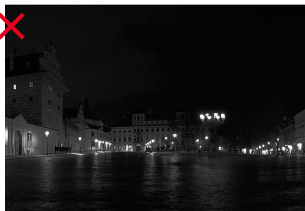
400 Příklad neúměrného veřejného osvětlení ve významném veřejném prostoru. Charakter vyzařování použitých svítidel zajišťuje pouze osvětlení komunikací. Celkový vjem veřejného prostoru je potlačen [ Praha 1, Hradčanské náměstí ]
