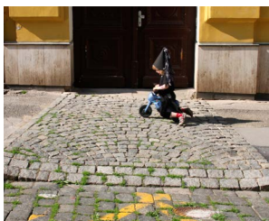
090 Napojení vjezdu na vozovku narušuje kontinuitu chodníku ani komfort a bezpečnost chůze [ Praha 7, Bubeneč ]
