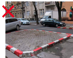
392 Plastové tvarovky slouží jako provizorní náhrada za obrubník. Dopravní vzhled však neodpovídá městskému prostředí a měl by být revidován. Tento prvek nesmí sloužit pro trvalé použití ve městě a je třeba vždy zvážit přiměřenost a míru použití [ Praha 7, Letná ]
