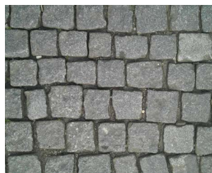
267 Žulová dlažba z drobných kostek 10 x 10 cm Použití: sdílené komunikace, zvýšené křižovatky, parkovací zálivy, parkoviště historického a kompaktního města
