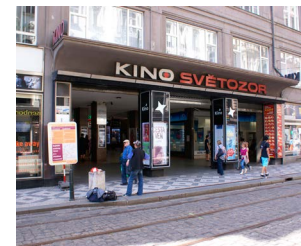
455 Ochrana před nepřízní počasí je tvořena vstupem do pasáže. Samostatný přístřešek zde není umístěn [ Praha 1, Vodičkova ]
