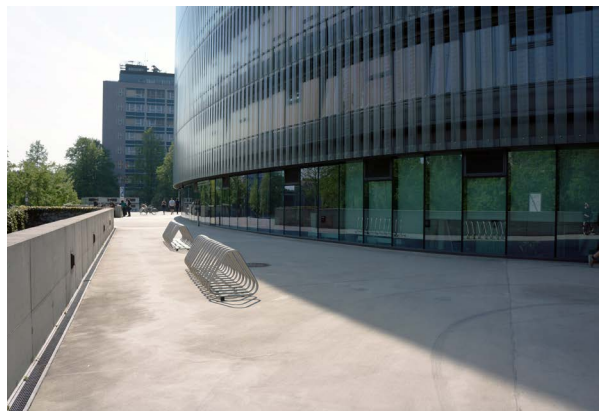
045 Vjezd do garáží není umístěn v rámci budovy, přesto nepřekáží pěšímu pohybu, netvoří vizuální bariéru. Je součástí kompozice celku. O přiměřeně vysokou zídku se lze opít. Projektil (2009) [ Praha 6, Národní technická knihovna ]
