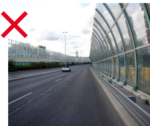
531 Protihlukové stěny užívané na městských komunikacích, které mají potenciál být městskou ulicí je zásadně nevhodné [ Praha 4, Modřanská ]
