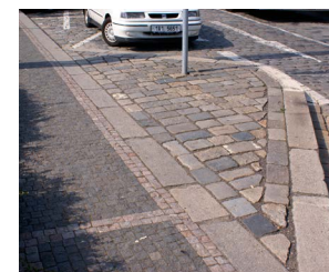
104 Rozšíření chodníkové plochy u parkovacího zálivu při zachování přímé obruby a s materiálovým odlišením přidané části [ Praha 1, Klárov ]
