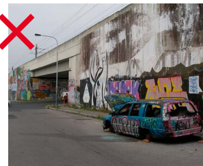
238 Samostatné tramvajové estakády ve městě jsou nepřipustným řešením. Nevytvářejí přirozené městské prostředí a výrazným způsobem rozdělují prostor města. Vytvářejí kolem sebe vnitřní periferie [ Praha 12, Modřanská tramvajová trať ]
