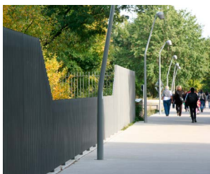
508 Vhodné oplocení areálu, barevně i designově koresponduje s okolím, umožňuje průhled a je kvalitní vně i uvnitř [ Německo, Berlín, Park am Gleisdreieck ]
