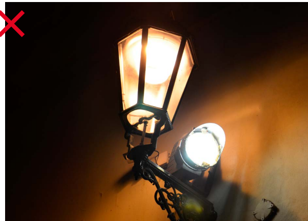
414 Nevhodná poloha a výrazné pohledové uplatnění svítidla architekturního osvětlení [ Praha 1, Zlatá ]
