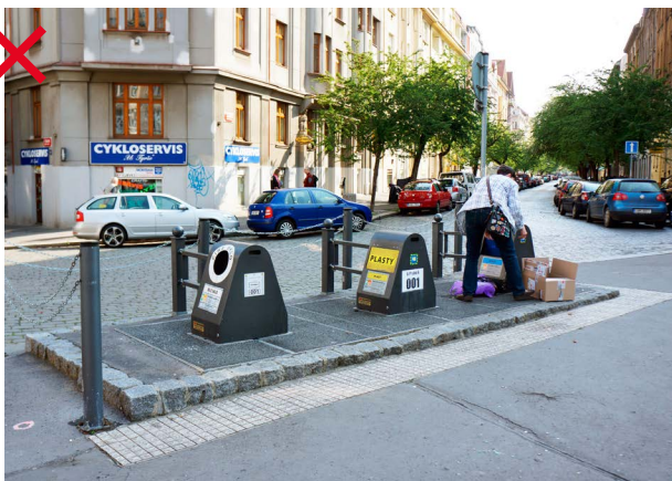
446 Bariérové řešení společně s rameny, která utvářejí prostorové bariéry popírají principiální výhody podzemních kontejnerů [ Praha 6, Dejvická ]
