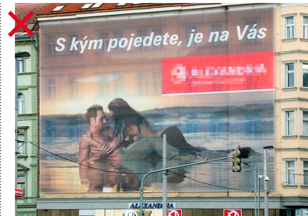
574 Plachta zakrývající fasádu objektu mění vzhled budovy, znemožňuje její plnohodnotné užívání a ohrožuje bezpečnost provozu [ Praha 3, Vinohradská ]
