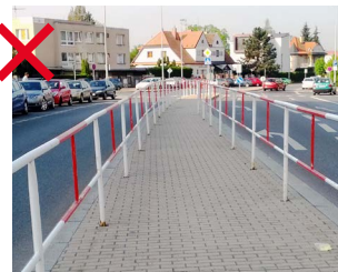
493 Příklad nadbytečného užití zábradlí [ Praha 4, Antala Staška ]
