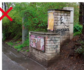
366 Nekoncepční a nezkoordinované umístění různorodých skříní technické a dopravní infrastruktury často i při snaze je sdružovat vede ke zcela neuspokojivým výsledkům [ Praha 2, Karlovo náměstí ]
