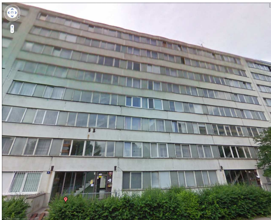
Fotografie č. 5: Příklad bytového domu ponechaného v původním stavu (sídliště Prosek)
