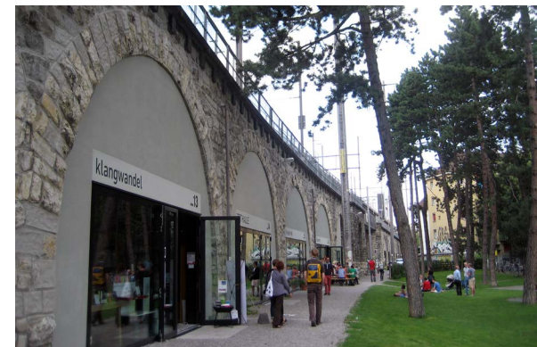
063 Viadukt v městském prostředí nevytváří takovou bariéru jako vedení železnice na valu. Je propustnější pro pohyb a oblouky viaduktu se dají využít i jako alternativní parter, čímž ožívují přilehlá prostranství [ Švýcarsko, Curych ]
