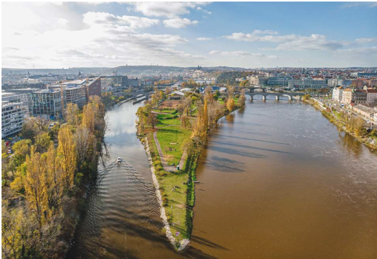
Za kurty se nachází zastřešený skatepark, v prostředním oblouku viaduktu vodní slalom. zdroj: IPR Praha
