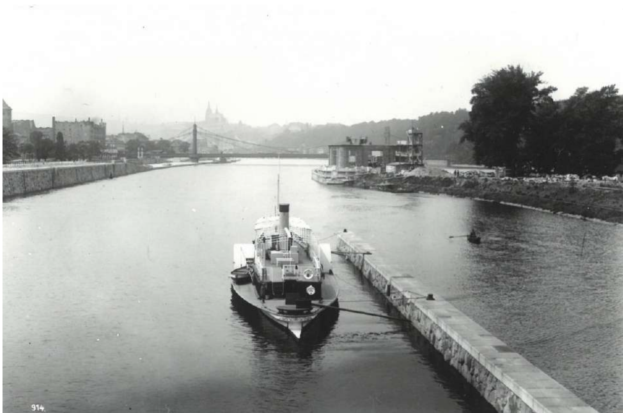
Panorama Pražského hradu s rozestavěnou budovou elektrárny a kotvicím parníkem. zdroj: IPR Praha
